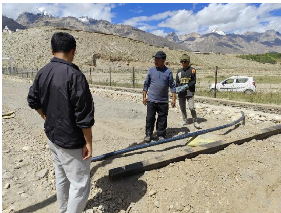
Figure 25 pose du pipe pour enterrer le câble électrique venant du solar camp de l'autre côté de la route
