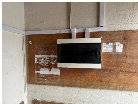
Figure 23 Un tableau électrique en remplacement d'un fouillis de prises
