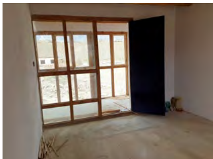
Chambre peinte vue de l'intérieur (juillet 2019)
