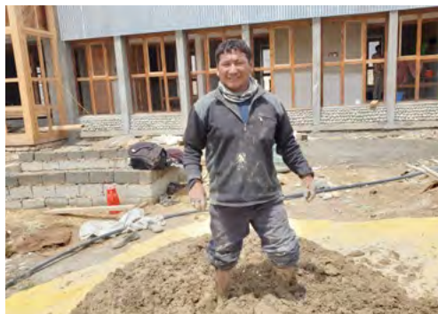
Plâtrier local préparant le mélange terre/paille/eau/ciment
