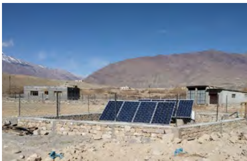
Clôtures posées autour des panneaux photovoltaïques des pompes et du RBP
