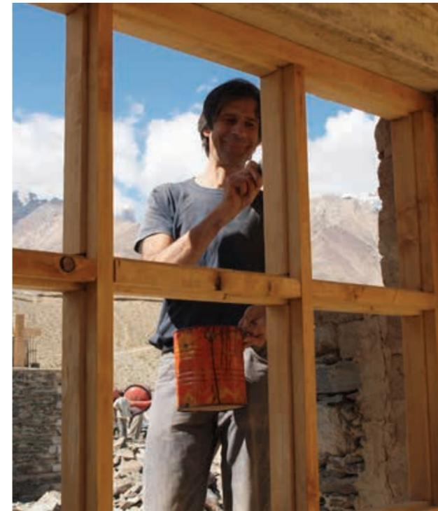
Ici « lapin Bertrand » (lapin=manœuvre en langage de charpentier) en train de passer une couche d'huile de lin.
