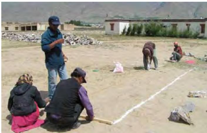
Traçage effectué par les conducteurs de travaux et ouvriers, en suivant les Center Lines marquées préalablement avec des cordes installées par Vanessa et Douchan.
